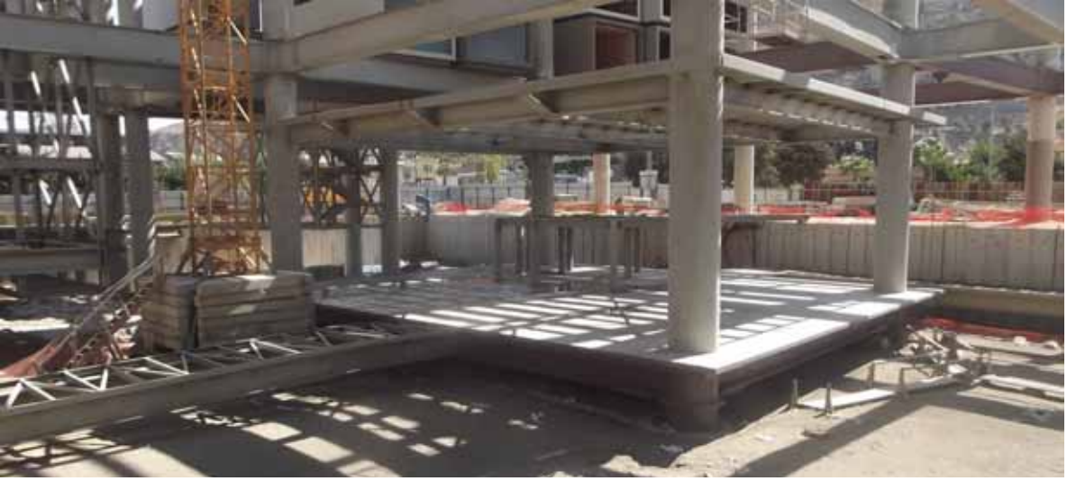
Şekil 13. Kirişlerin Kolon Montajı
