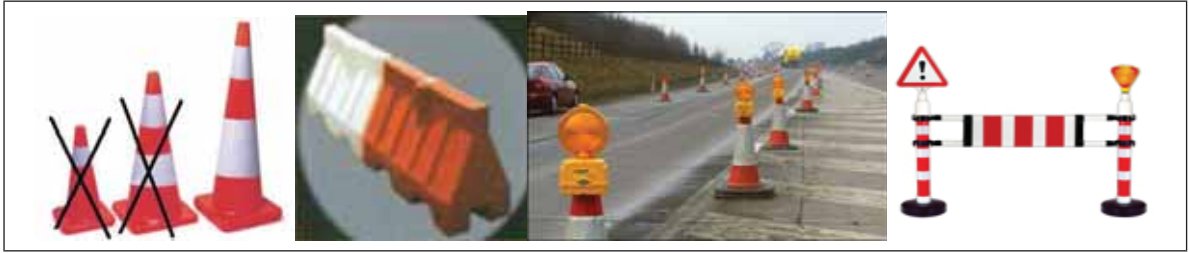
Şekil 5: Yol çalışmalarında kullanılan malzeme türleri.
