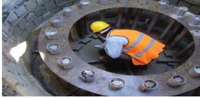
Şekil 8. Ankranj Bulonlarının Montajı
