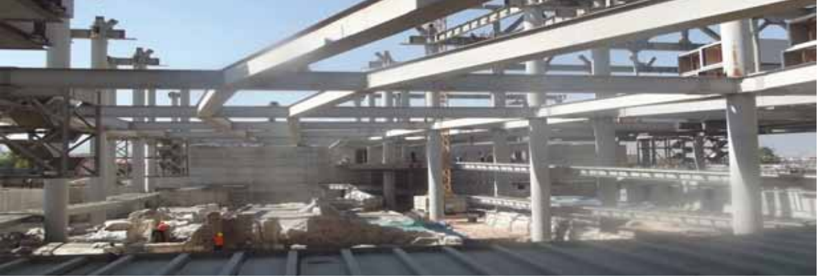
Şekil 12. Çelik kolonların Montajı
