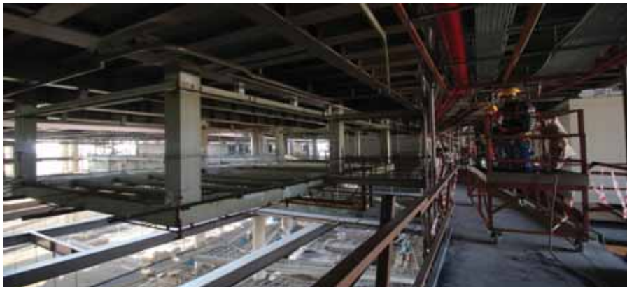
Şekil 21. Çalışanların Kişisel Koruyucu Ekipmanlarla Çalışması
