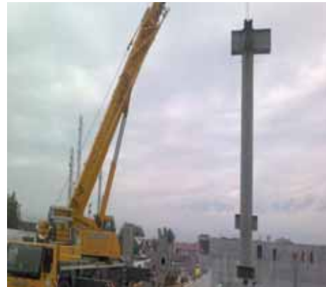
Şekil 11. Çelik İmalatı Montajı
