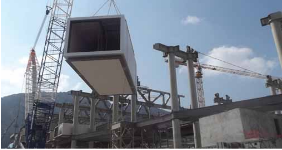
Şekil 16. Odaların Montajı-I
