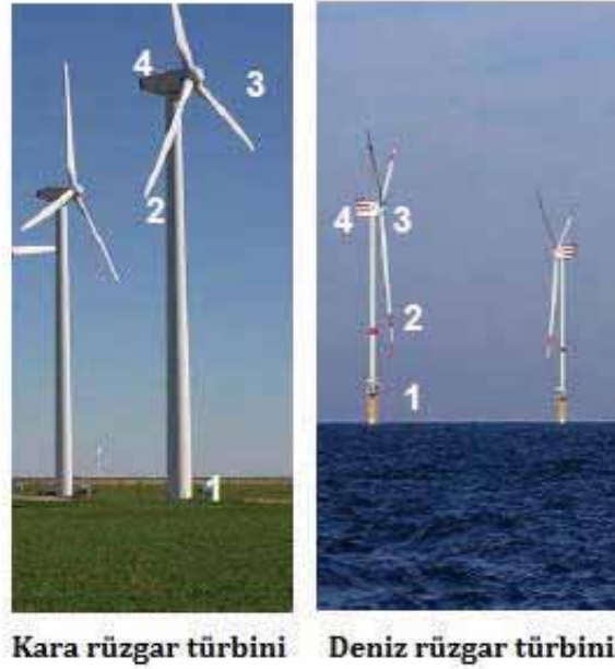
Şekil 1: Rüzgar türbini bileşenleri; (1) Kule, (2) Yapraklar, (3) Göbek, (4) Nasel
