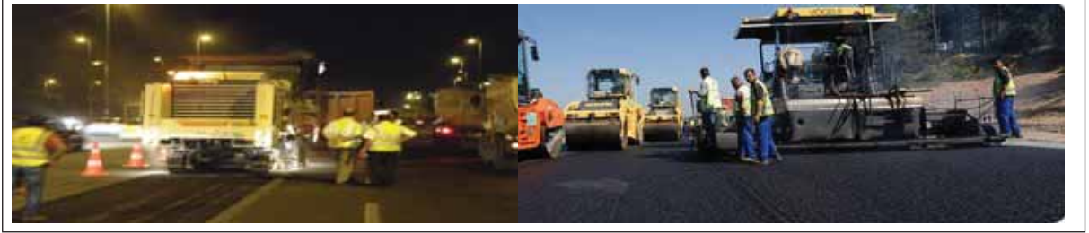
Şekil 3: Çalışma alanında uyarıcı kıyafetlerin kullanılması.
