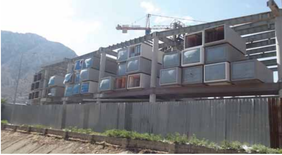
Şekil 17. Odaların Montajı-II
